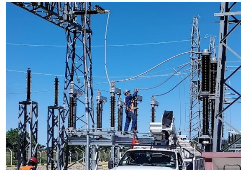
Subestación Eléctrica San Julián y calibración de protecciones en celdas de potencia.
