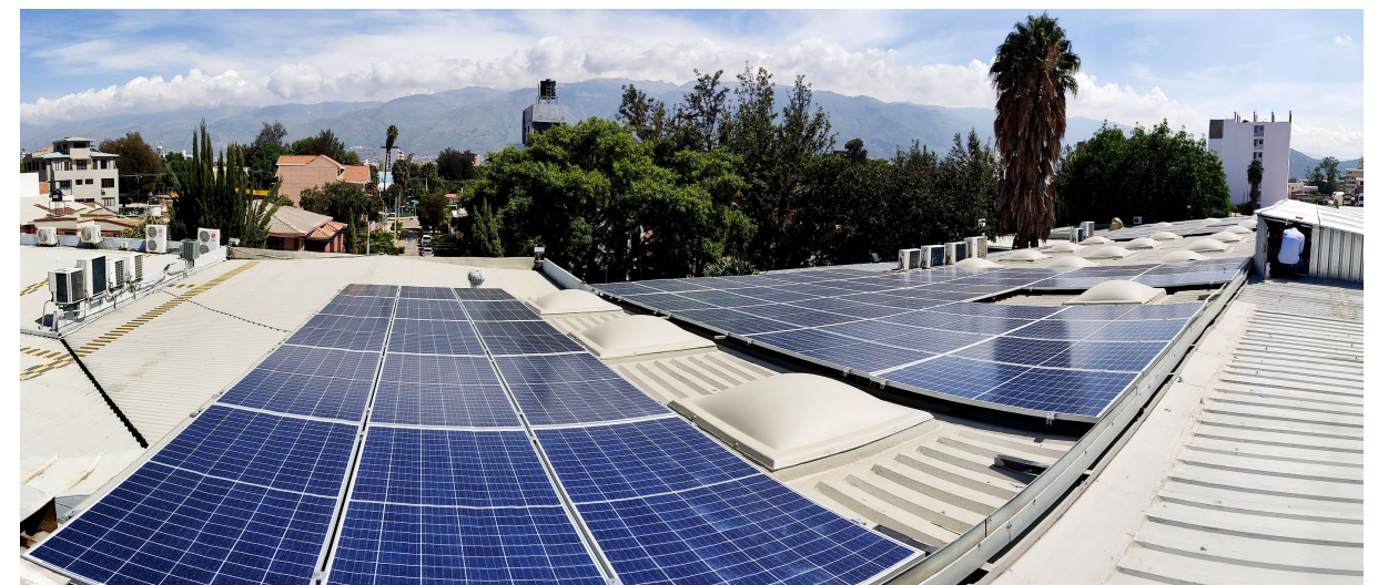
Proyecto Generación de Energía Distribuida: Instalación de módulos fotovoltaicos.
