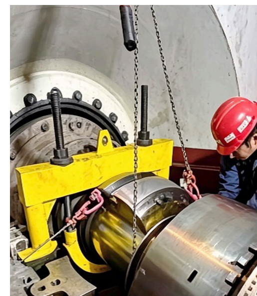
Mantenimiento de cojinetes de la unidad GCH-12.
