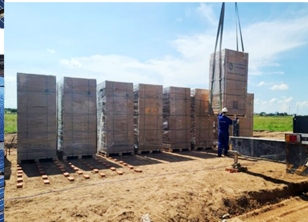
Recepción de paneles fotovoltaicos en obra en la Planta Solar Fotovoltaica Viru Viru.
