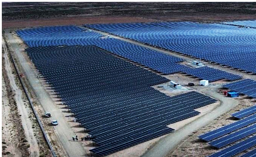
Vista de estructuras y paneles de la ampliación Uyuni Fase II.
