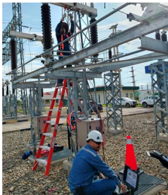
Subestación Eléctrica Warnes y verificación de parámetros eléctricos.
