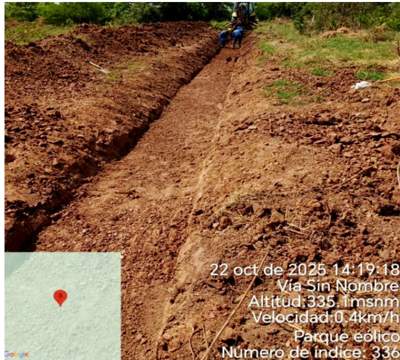
Trabajos de mejoramiento del sistema de drenaje del Parque Eólico San Julián.
