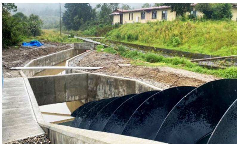
Vista Canal de Derivación - Proyecto Piloto Planta Hidroeléctrica de Pasada en Corani.
