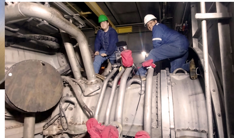
Mantenimiento de cámaras de combustión.
