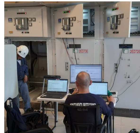
Subestación Eléctrica San Julián y calibración de protecciones en celdas de potencia.
