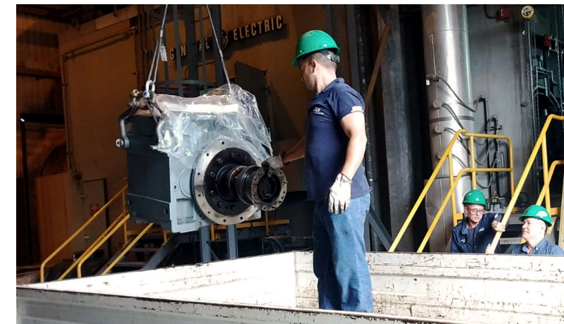
Mantenimiento de virador hidráulico.
