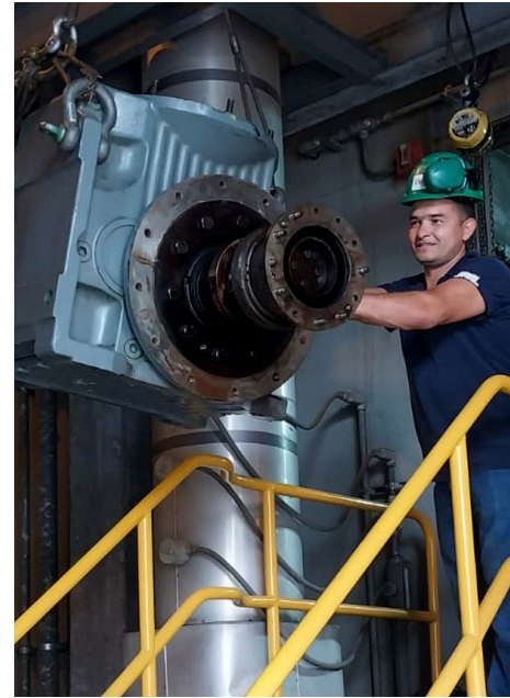
Mantenimiento de virador hidráulico.
