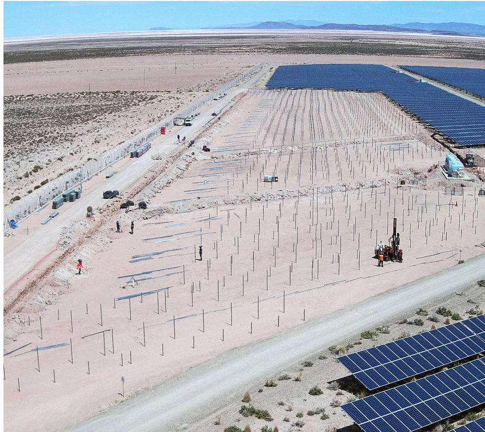
Vista aérea Hincado en Planta Solar Fotovoltaica Uyuni Fase II.
