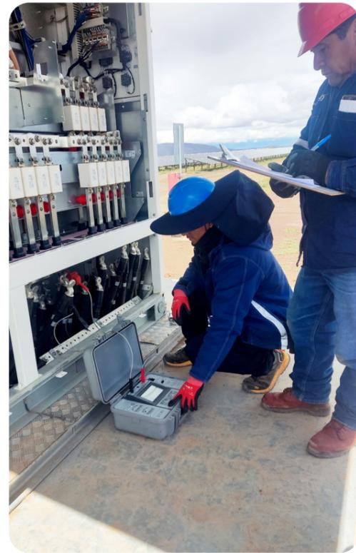
Ensayos Eléctricos en Inversores.
