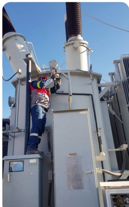
Instalación del Analizador de Gases Disueltos en el Transformador de Potencia.
