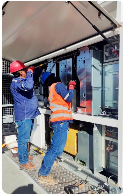
Reemplazo de POWER STACKS en Inversores.
