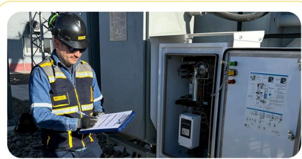
Puesta en marcha del Analizador de Gases Disueltos en el Transformador de Potencia.
