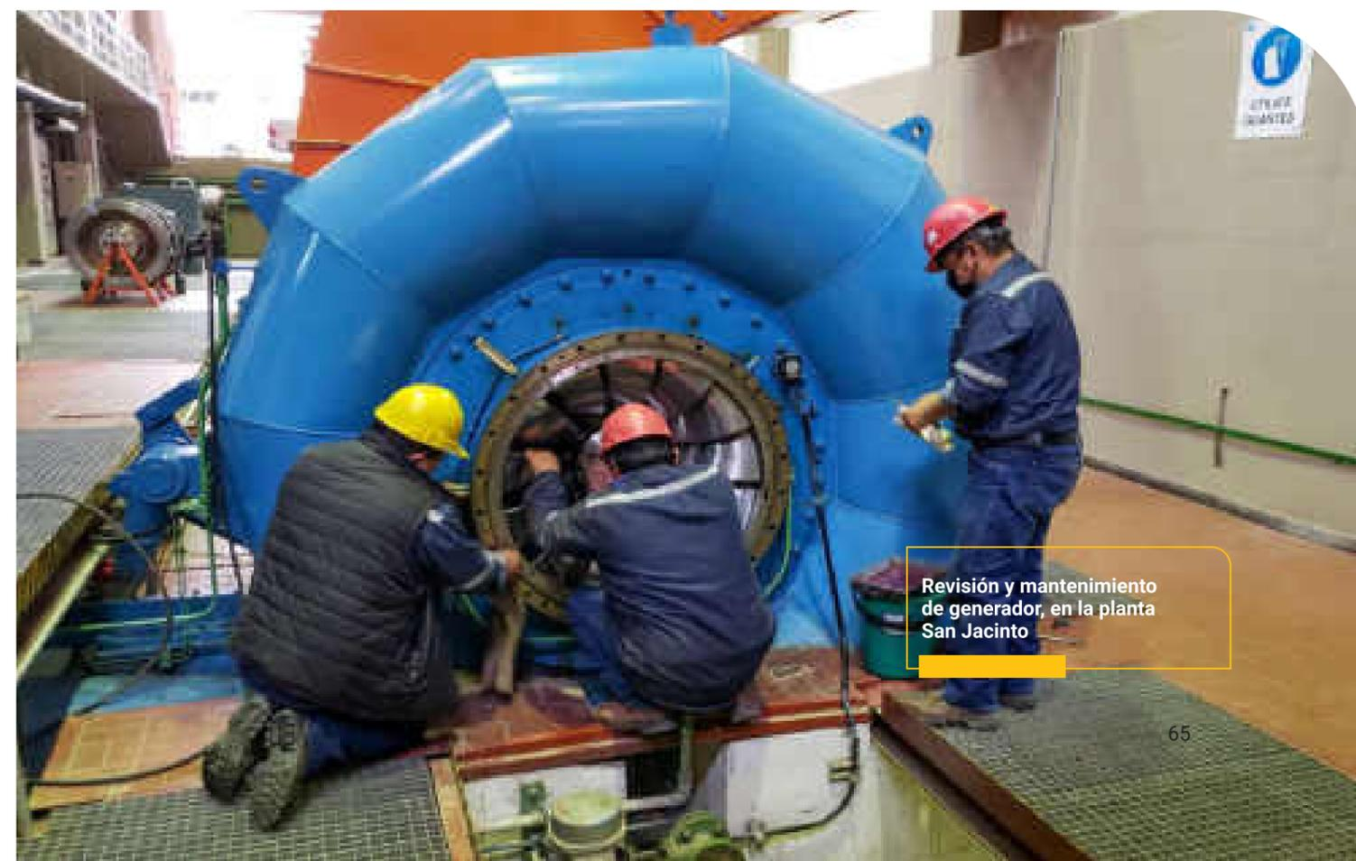
Revisión y mantenimiento de generador, en la planta San Jacinto
