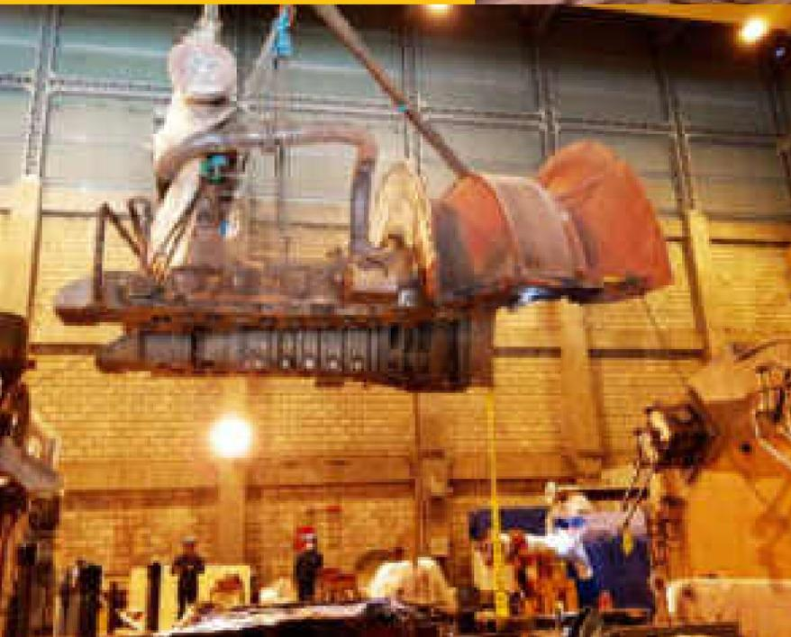
Desmontaje de carcasa de turbina.
