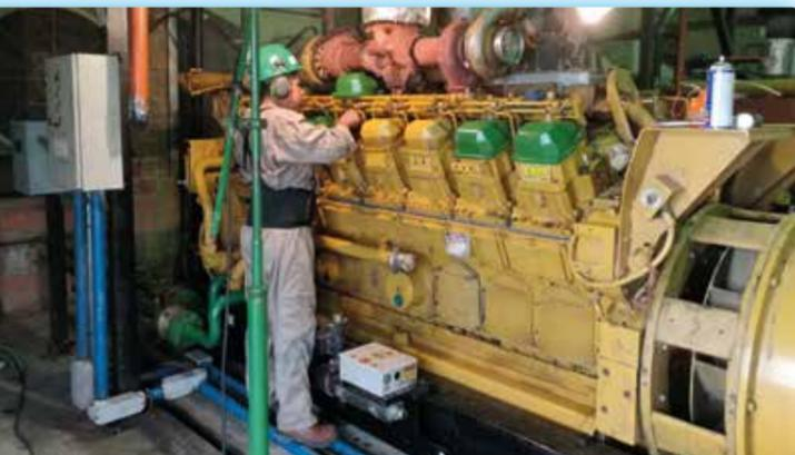
Dentro del Plan Anual de Mantenimientos, en 2018 se realizaron cinco mantenimientos mecánicos mayores (Overhaules) en las Unidades Caterpillar 3516 MOS 2, MOS 4, MOS 5, MOS 6 y MOS 7, y dos mantenimientos mayores – reacondicionamientos en extremo superior (Top-End) en las unidades MOS 8 y MOS 10, al haber cumplido las horas recomendadas por el fabricante.
