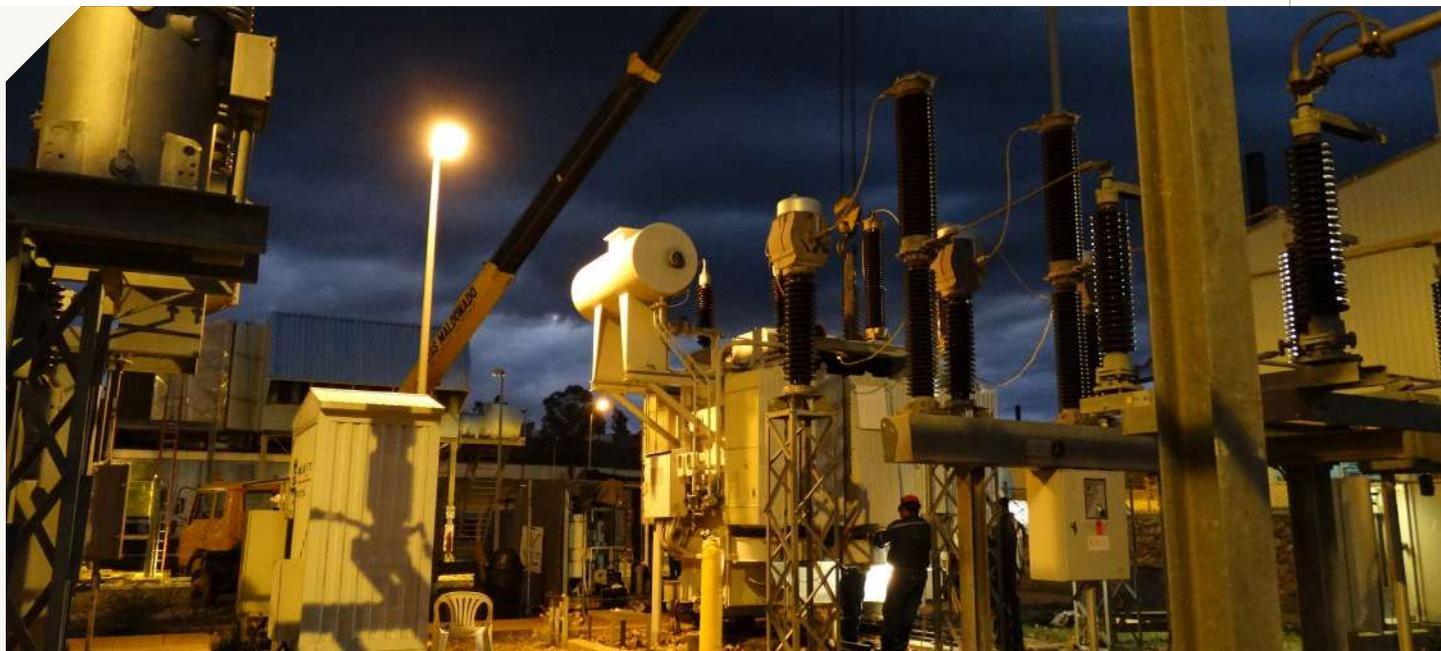
Durante el mes de diciembre 2016, aprovechando la parada por mantenimiento mayor de la Unidad ARJ-8, se realizó un mantenimiento general del Transformador TRARJ06908 – T8 de Subestación Aranjuez marca Pauwells de 25 MVA. El mismo incluyó el filtrado y resecado del aceite de transformador, boroscopia, reemplazo de intercambiador de Taps, reemplazo de empaquetaduras, ensayos eléctricos y comisionado de protecciones mecánicas y eléctricas.
