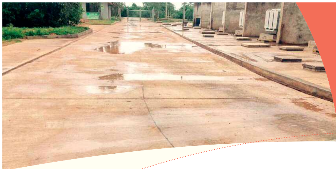
Vaciado de hormigón en calles y vías de circulación interna
