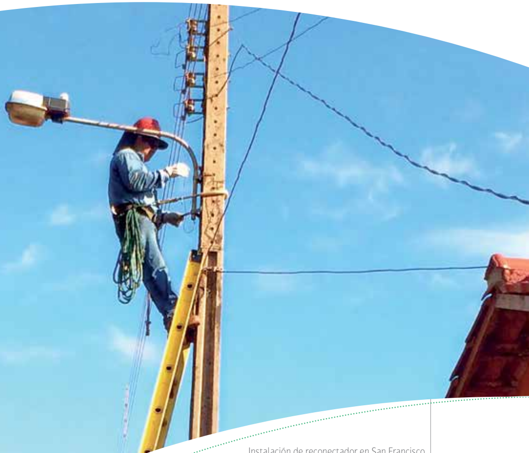
Instalación de reconector en San Francisco
