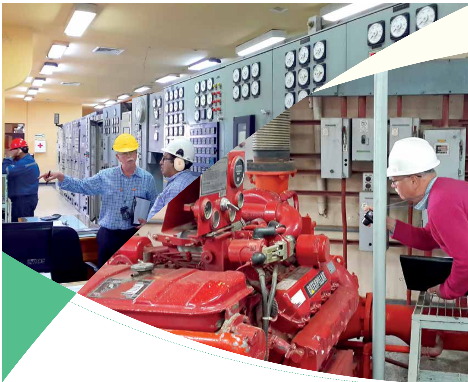
Inspección de riesgos Plantas Guaracachi y Aranjuez
