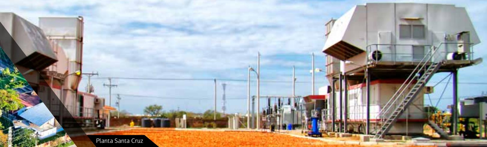
La Planta Termoeléctrica Santa Cruz, ubicada en la zona del Parque Industrial de la ciudad de Santa Cruz de la Sierra, cuenta con 42,3 MW de potencia efectiva en sitio. Tiene dos turbogeneradores Frame V y entrega su energía generada al SIN en el área oriental.
