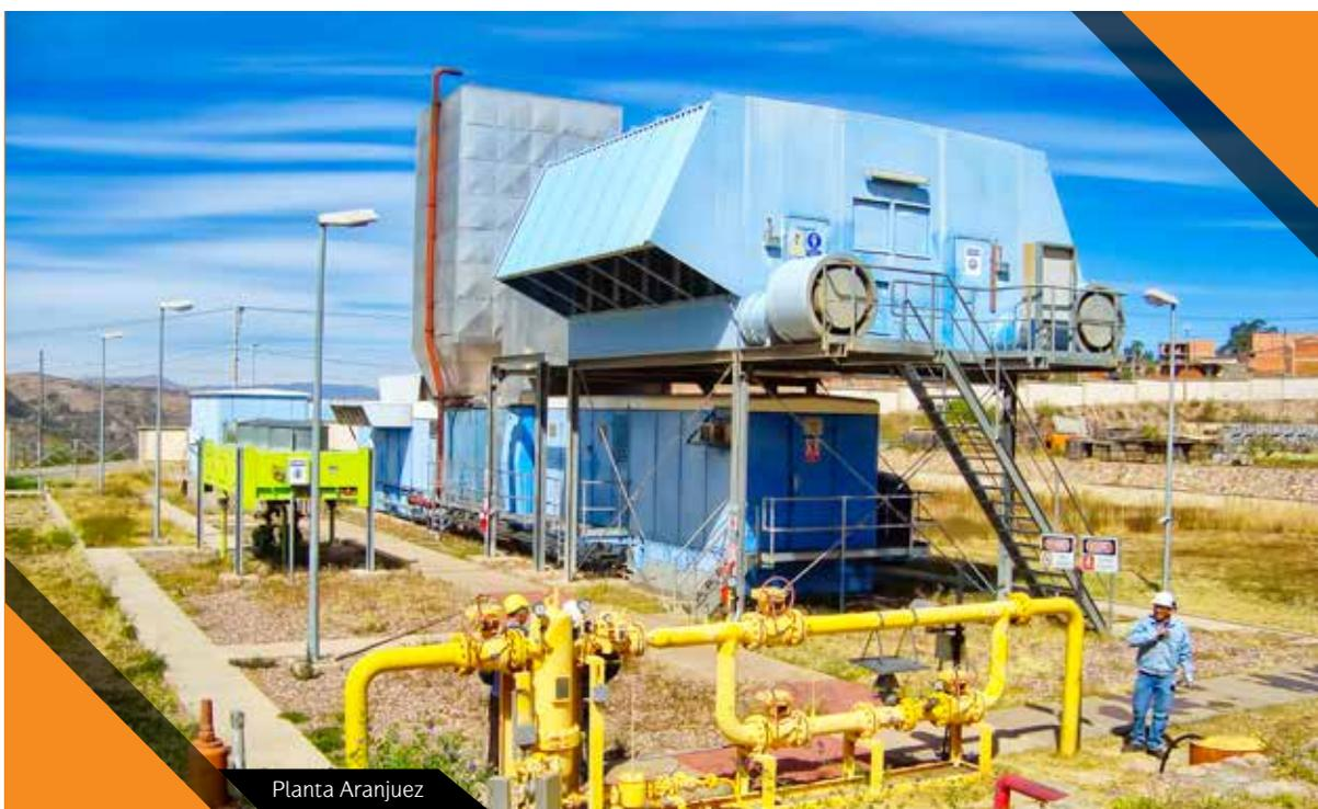
La Planta Termoeléctrica Aranjuez, ubicada en la zona de Aranjuez en un área periurbana de la ciudad de Sucre, tiene un turbogenerador a gas natural de 18,4 MW, tres motores dual a gas natural y diesel, con una potencia de 7,6 MW, y siete motores a gas Jenbacher, con una potencia de 10,7 MW, totalizando una potencia instalada de 36,7 MW en toda la Planta.
