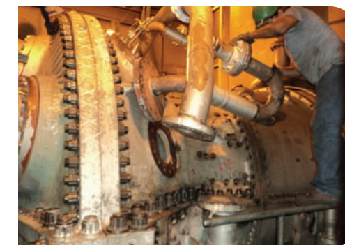
Mantenimiento gases calientes - Unidad GCH-10
