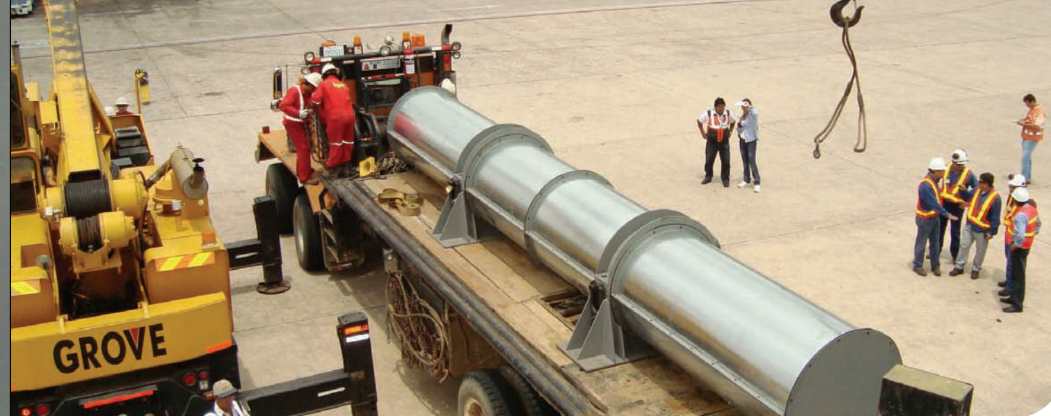
Descarguo y transporte terrestre de rotor reparado - Unidad GCH-12
