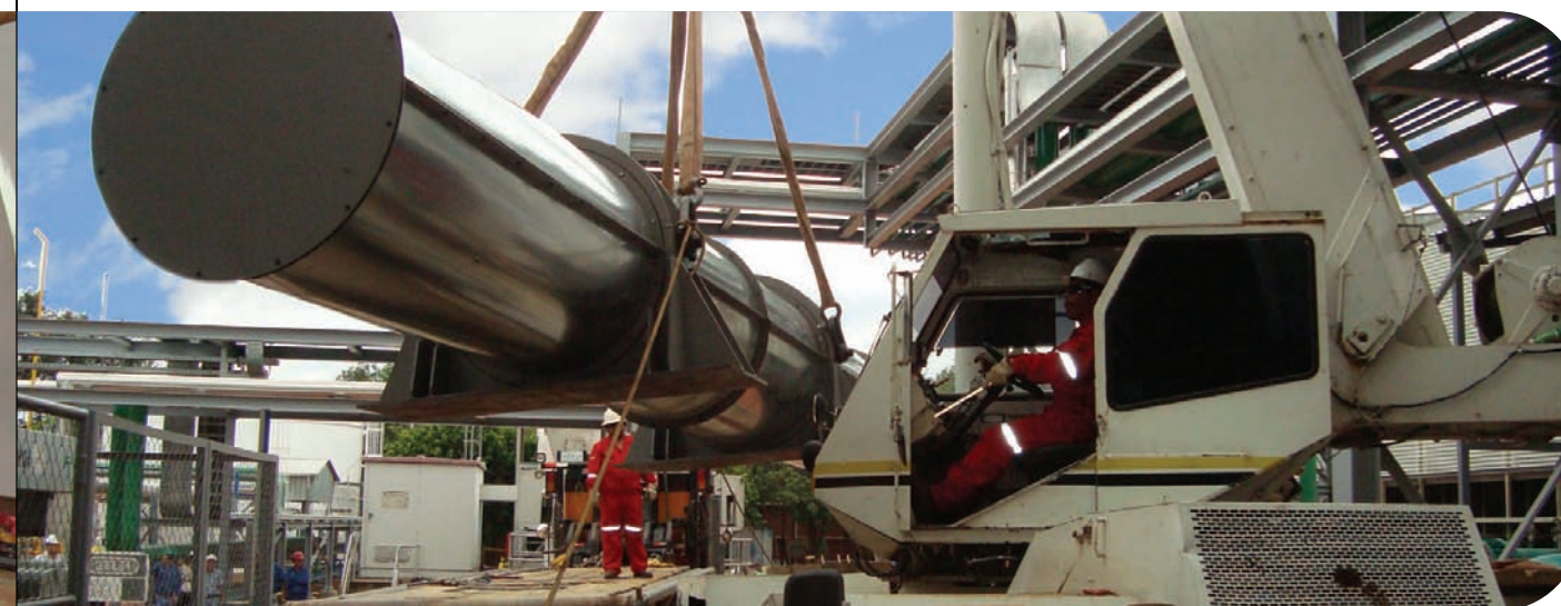
Izaje de Rotor reparado Unidad GCH-12
