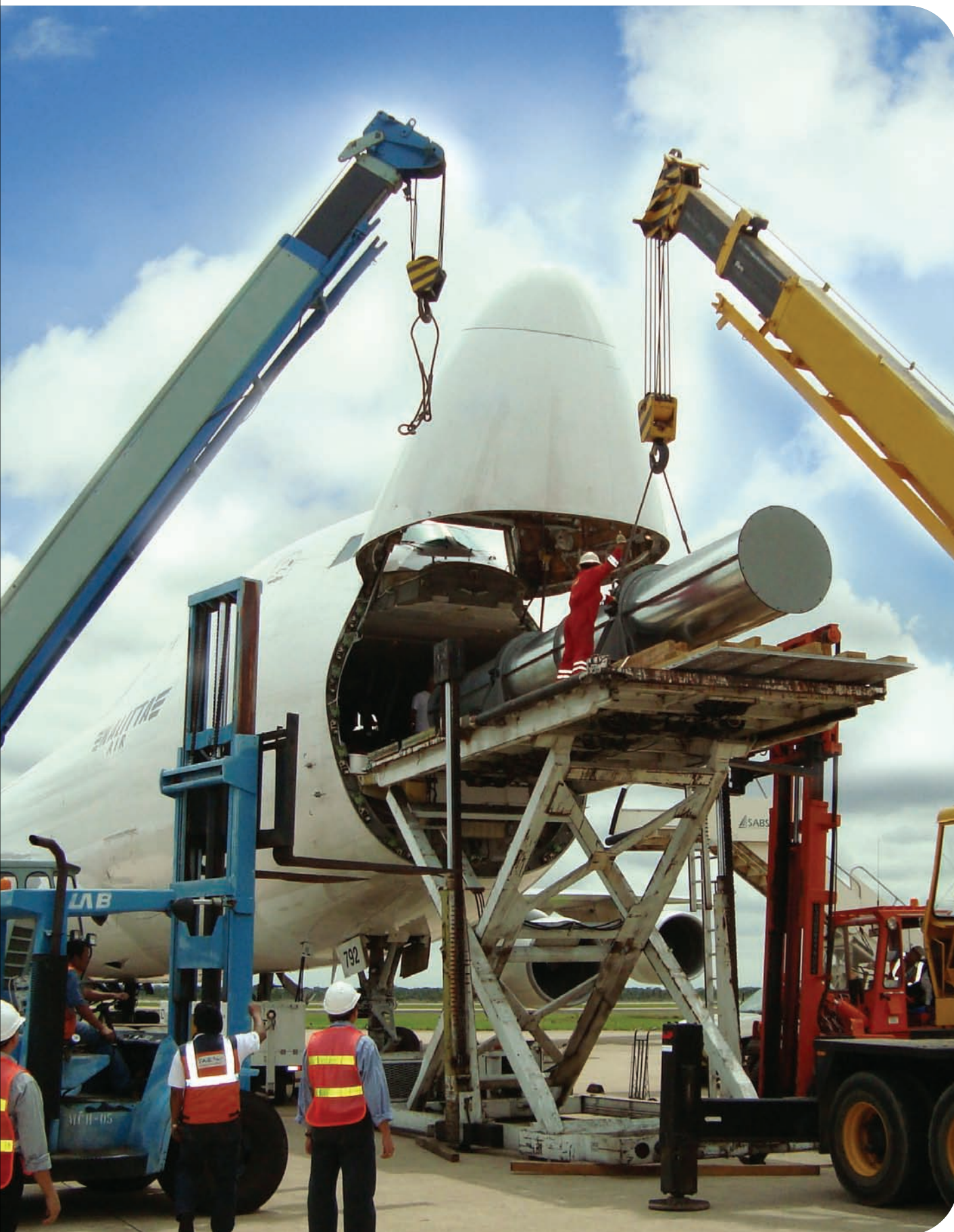
Descarguo rotor reparado - unidad GCH 12 - Ciclo combinado
