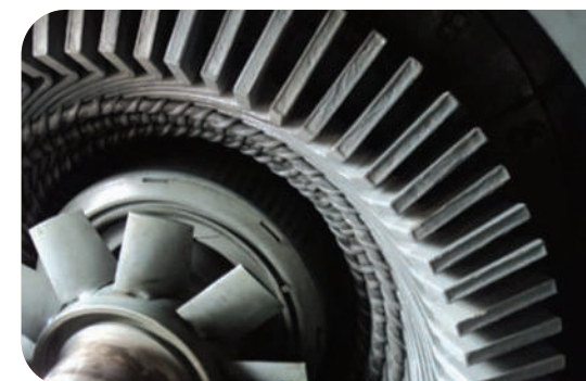
Mantenimiento Camara de Combustion GCH-10
