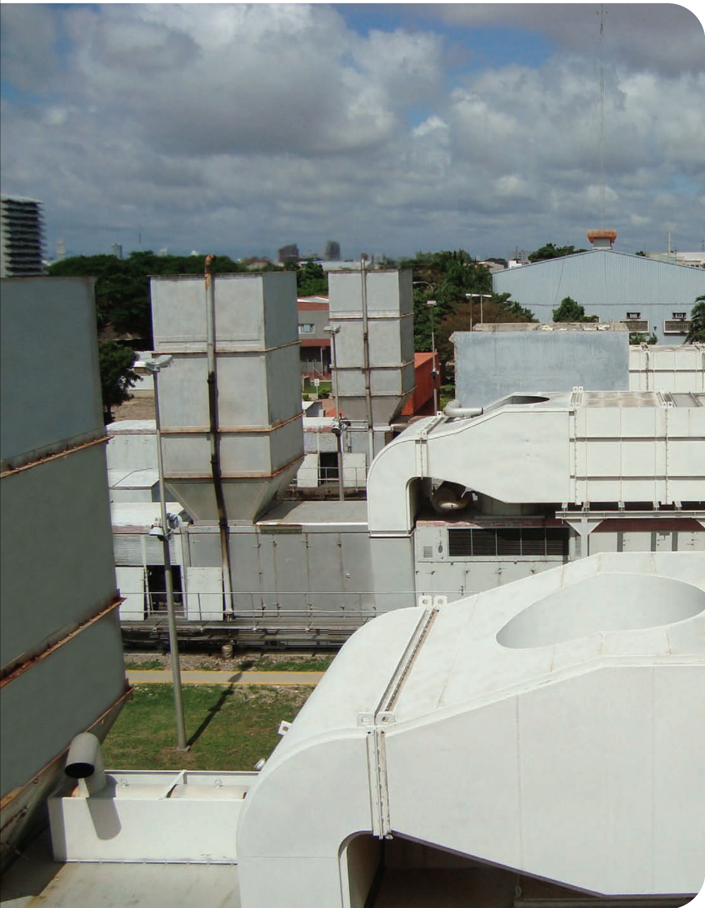
Unidades de generación Frame V - Ciclo simple - Planta Guaracachi
