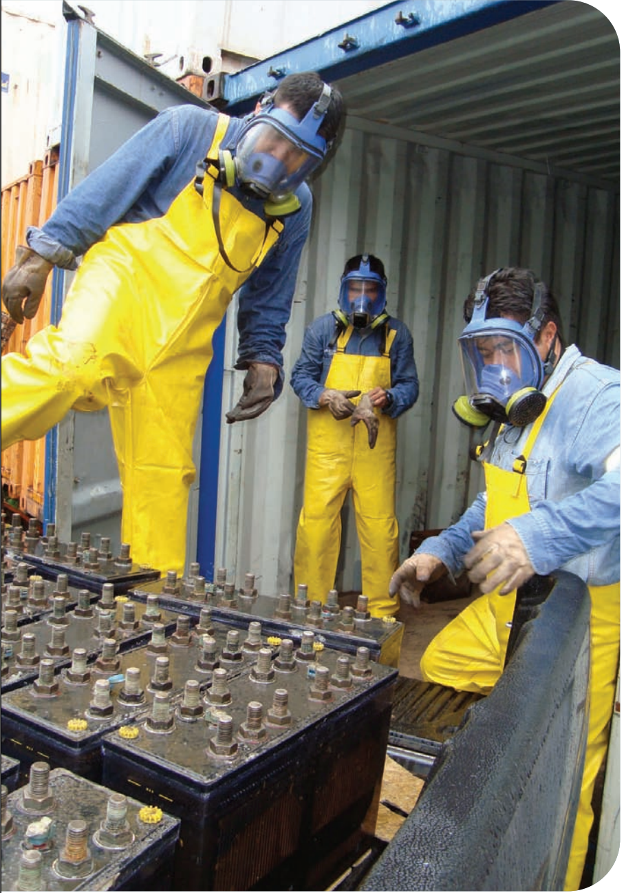
Desmontaje y almacenamiento provisional baterías Níquel Cadmio
