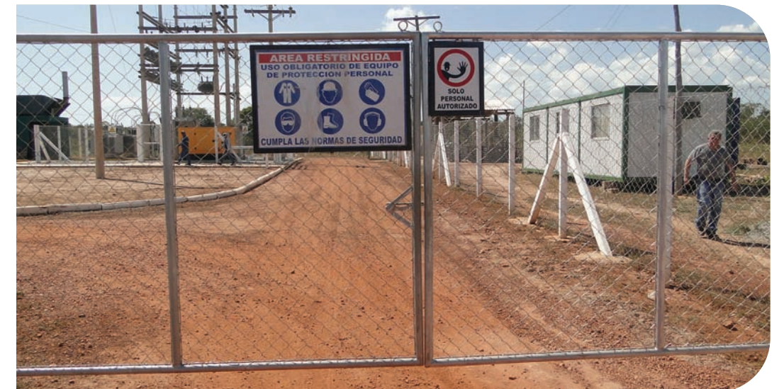
Planta Termoeléctrica San Matías
