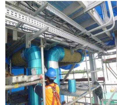
Montaje del aislamiento térmico, Caldero HRS 32; Bloque 30
