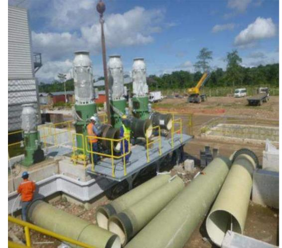
Montaje de tubería de PRFV (poliester reforzado con fibra de vidrio), CT40; bloque 40
