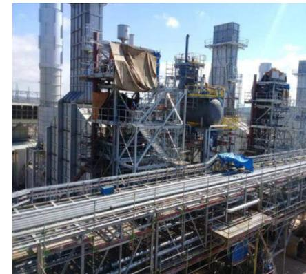
Montaje de tuberías y torre Benson Caldera HRSG 12, Bloque 10
